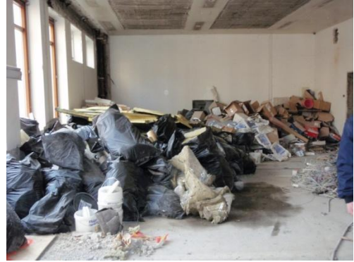
Sortering av avfall ved riving av bygg
